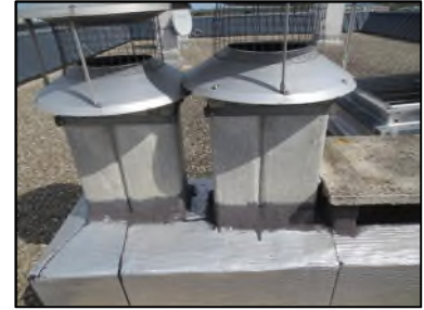
Photo N° 646 AMIANTE CIMENT -- Toiture terrasse Toiture Ventilation haute (Fibres-ciment)
